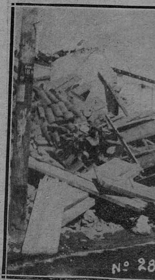
EN LA CALLE DE 10 DE OCTUBRE. —Prendida en 10 de Octubre, enteramente destruidas seis casas de
