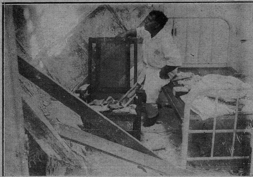
EN EL SANATORIO "CONCEPCION ARENAL".—Modesto, conocido y po- pular practicante del Sanatorio del Centro Gallego, y muy querido entre los socios del mismo, rodeado de los escombros a que quedó reducido su aparta- mento por los derrumbes de parte del techo y las paredes del mismo.
