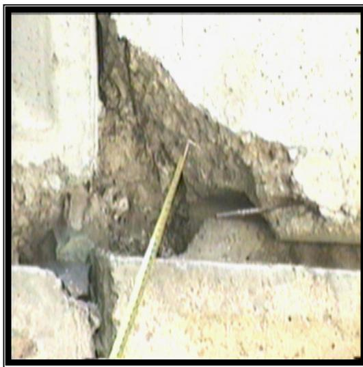
Foto 18. Detalle de la situación que presenta la unión de los paneles prefabricados en un edificio típico de los existentes en el barrio Los Edificios del sistema Gran Panel. (Foto del autor).
