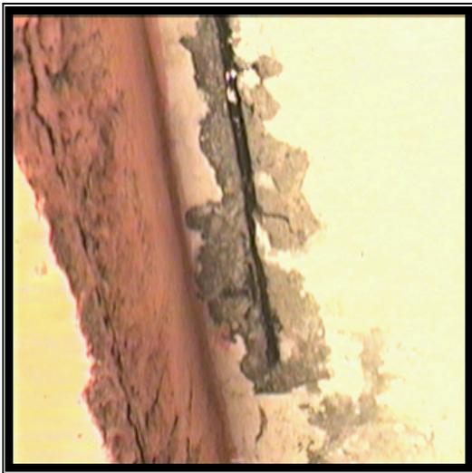
**Foto 15.** Patología de las construcciones utilizadas como edificaciones multifamiliares, donde se observa un alto grado de corrosión. Barrio Los edificios, Pílon. (Foto del autor)
