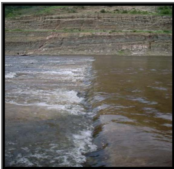
**Foto 17.** Nuevo vertimiento de la presa Silantro tras el paso de la Depresión Tropical Wilma por el sur de las provincias orientales, continuando el proceso de erosión remontante en el aliviadero. (Cortesía de la Ing. Ibia Vega)
