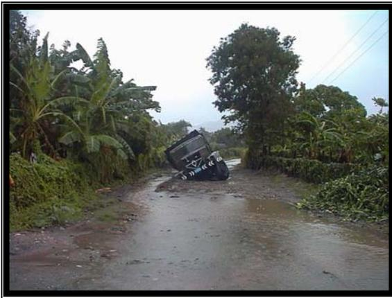
**Foto 31. Obsérvese la vulnerabilidad de los viales existentes en la mayor parte del municipio de Pilón, lo cual genera la incomunicación en caso de intensas lluvias. Junio 2002. (Foto del autor).**
