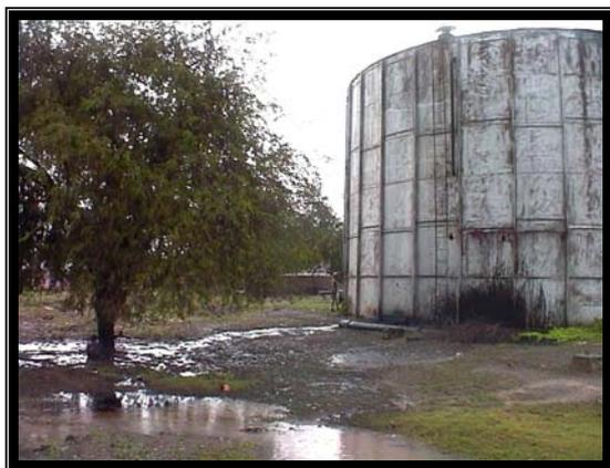
**Foto 35. Derrame de hidrocarburo catalizado por las lluvias de junio del 2002, desde tanque de combustible en mal estado, ubicado en el Batey Azucarero de Pilon. (Foto del autor).**
