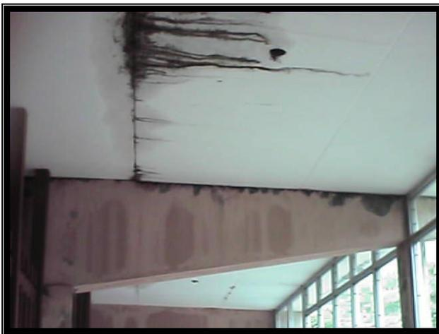
**Foto 13. Obsérvese el estado de la cubierta producto de la mala impermeabilización. (Foto del autor).**
