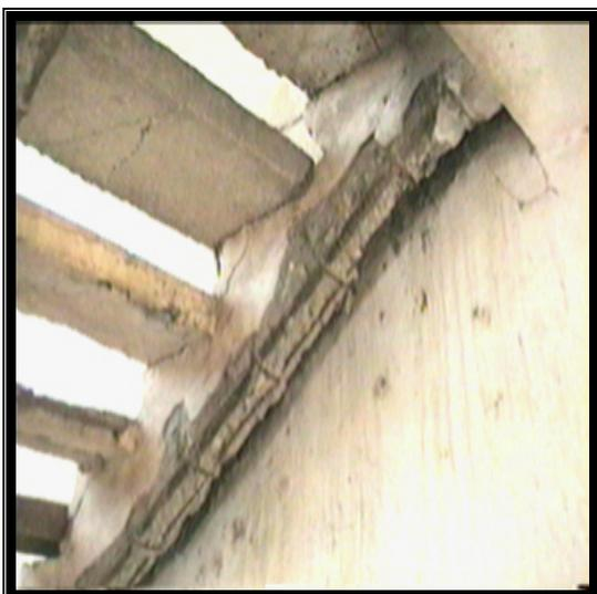
Foto 19. Situación existente en un edificio del sistema E-14, donde la calidad inicial de la obra, unido a constantes filtraciones y la agresión medioambiental han incrementado la corrosión y su vulnerabilidad (Foto del autor).
