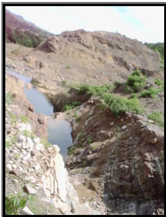
**Foto 15. Las condiciones geológicas típicas condicionan la continuidad del proceso erosivo e inducen un nivel de riesgo al aliviadero natural de este embalse. (Foto del autor).**
