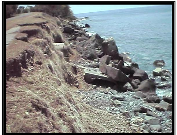
**Foto 10. Erosión de la carretera en el sector de Uvero, pone en peligro la vía. (Foto del autor).**
