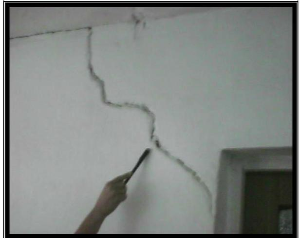
**Foto 12 . Grietas en pared producidas por el asentamiento diferencial y la acción combinada de sismos en la zona en 1998. (Foto del autor).**
