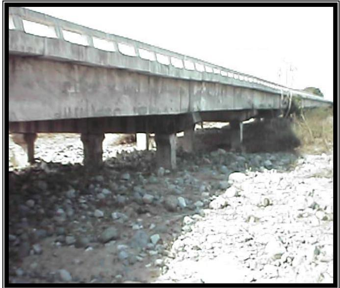
**Foto 4. Puente más largo de Cuba ubicado sobre el río Peladero, sin embargo la erosión fluvial amenaza con destruir su sector este. (Foto del autor).**
