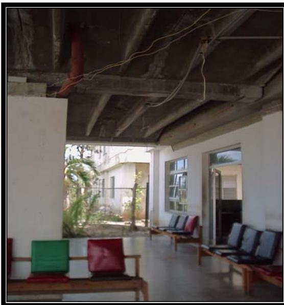
**Pérdida del falso techo y exposición de los sistemas eléctricos como consecuencia de la dirección de los vientos y la ubicación de la instalación.**
