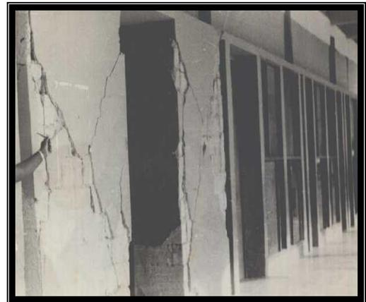
**Foto 4. Obsérvese la magnitud y tipo de agrietamiento producido en las construcciones existentes en Pílon. (Archivos del Departamento de Sismología, IGA).**
