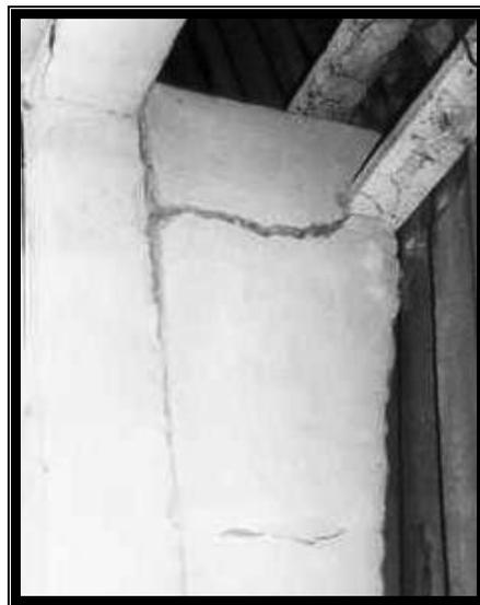
Foto 10. Grietas entre elementos estructurales y no estructurales, en 1992. (Foto del autor).
