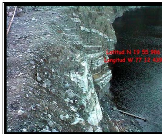
**Foto 2.** La presencia de tobas altamente tectonizadas, agrietadas y antropizadas, caracterizan la zona del aliviadero de este embalse. (Foto del autor).
