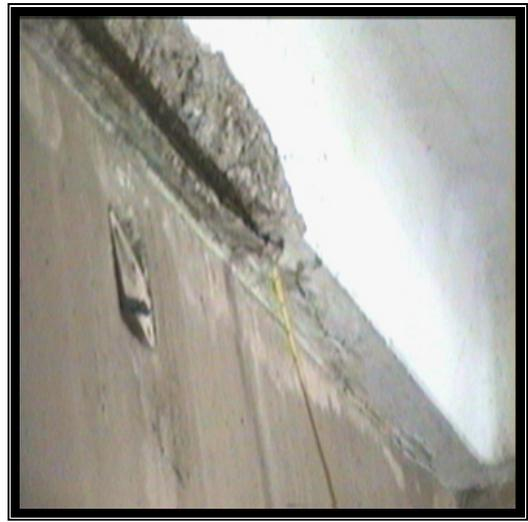
**Foto 16.** Situación de las construcciones en el reparto Los Edificios, donde las filtraciones y la corrosión presentes incrementan la vulnerabilidad de éstas. (Foto del autor)
