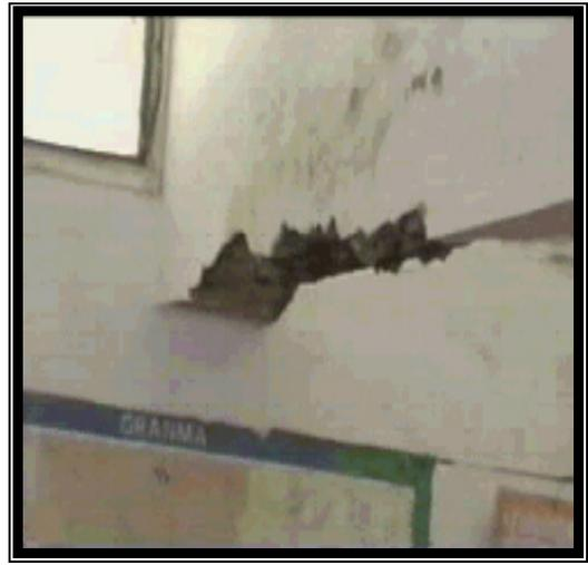
**Foto 14.** Estado de una viga afectada durante el sismo de 1976 en el aula de quinto grado, donde se aprecia además corrosión. (Foto del autor)
