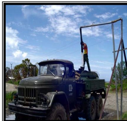
**El no funcionamiento de la potabilizadora y su sistema de rebombeo obligo a la instalación de un grupo electrógeno en un pozo alternativo .**
