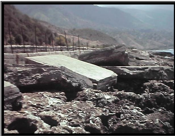
**Foto 9. Severidad de las penetraciones del mar en el sector de Las Piñas. (Foto del autor).**
