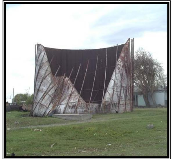
**Impacto sobre estructura metálica que evidencia la intensidad del viento.**
