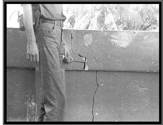
**Foto 2. Afectaciones a las construcciones que permitieron estimar la intensidad del sismo. (Cortesía del Lic. Manuel Serrano).**
