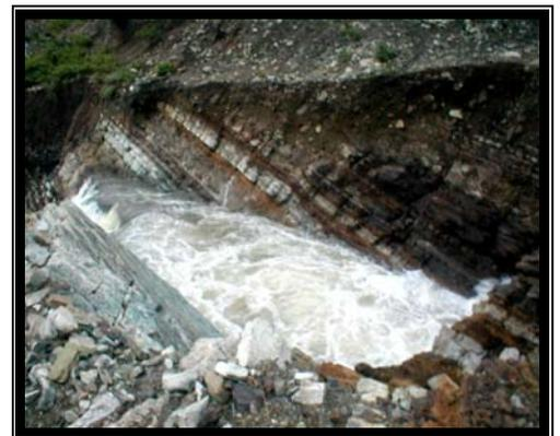
Foto 10. Erosión remontante en el aliviadero natural de la presa Silantro. (Cortesía del Ing. Eberto Hernández Suró).
