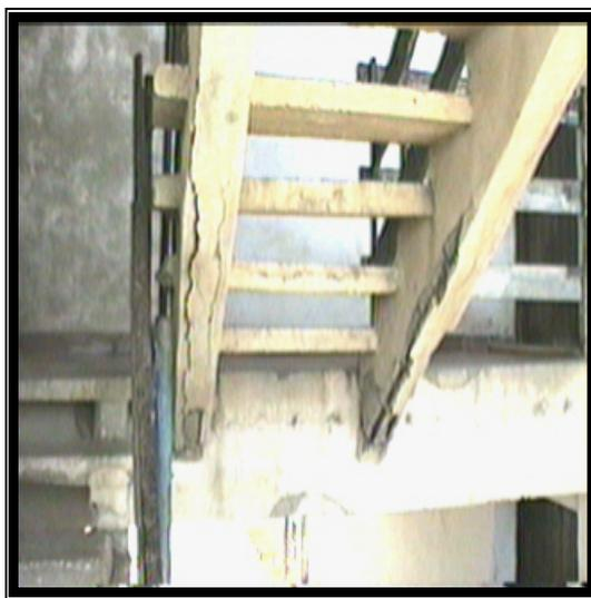
Foto 20. La corrosión es la patología más diseminada en Pílon, como consecuencia del uso de arena de mar no tratada, deficiencias en impermeabilización de cubiertas, aceros expuestos y falta de mantenimiento. (Foto del autor).
