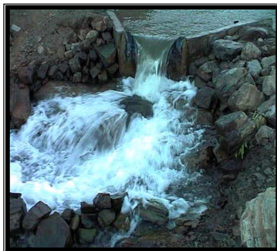
**Foto 6.** Nivel de pérdidas por filtración en la presa Silantro, que representaban un gasto superior a 10 litros por segundo. (Foto del autor).
