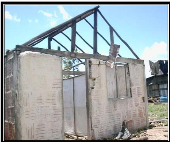
Construcciones de mampostería de baja calidad y estructuras de madera, pierden totalmente la cubierta, poniendo en peligro la vida de sus moradores en la carretera a Niquero.
