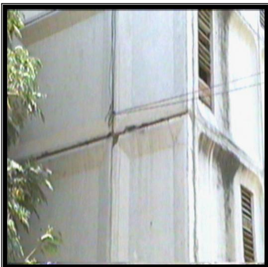
Foto 17. Estado de los edificios multifamiliares de Pílon, Sistema Gran Panel donde se aprecia una vulnerabilidad inherente a la calidad y proceso de ejecución de la obra. (Foto del autor).
