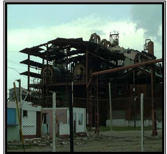
**En Niquero sufrieron afectaciones severas las estructuras metálicas del central, específicamente sus techos.**
